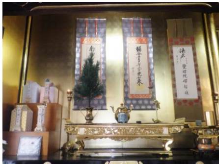
古くなった本堂の両脇間の金色の壁紙を貼り替え、美しさを取り戻した様子
